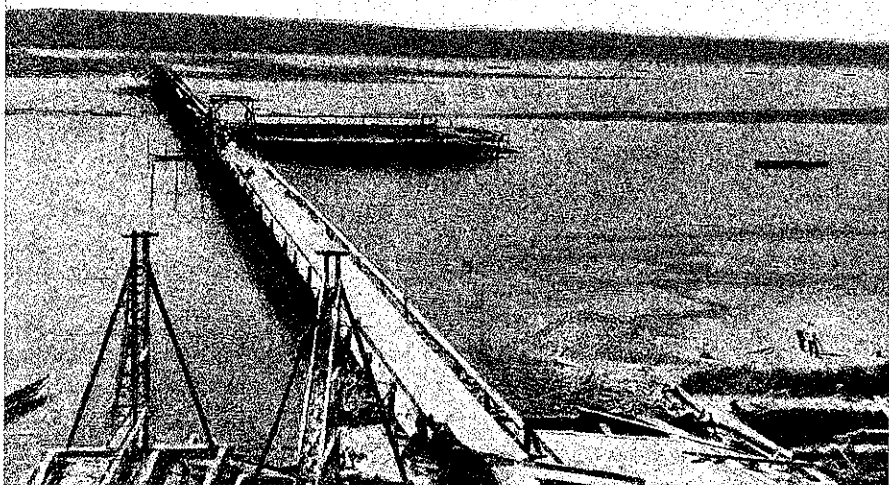
Временный мост через Иртыш. 1928
