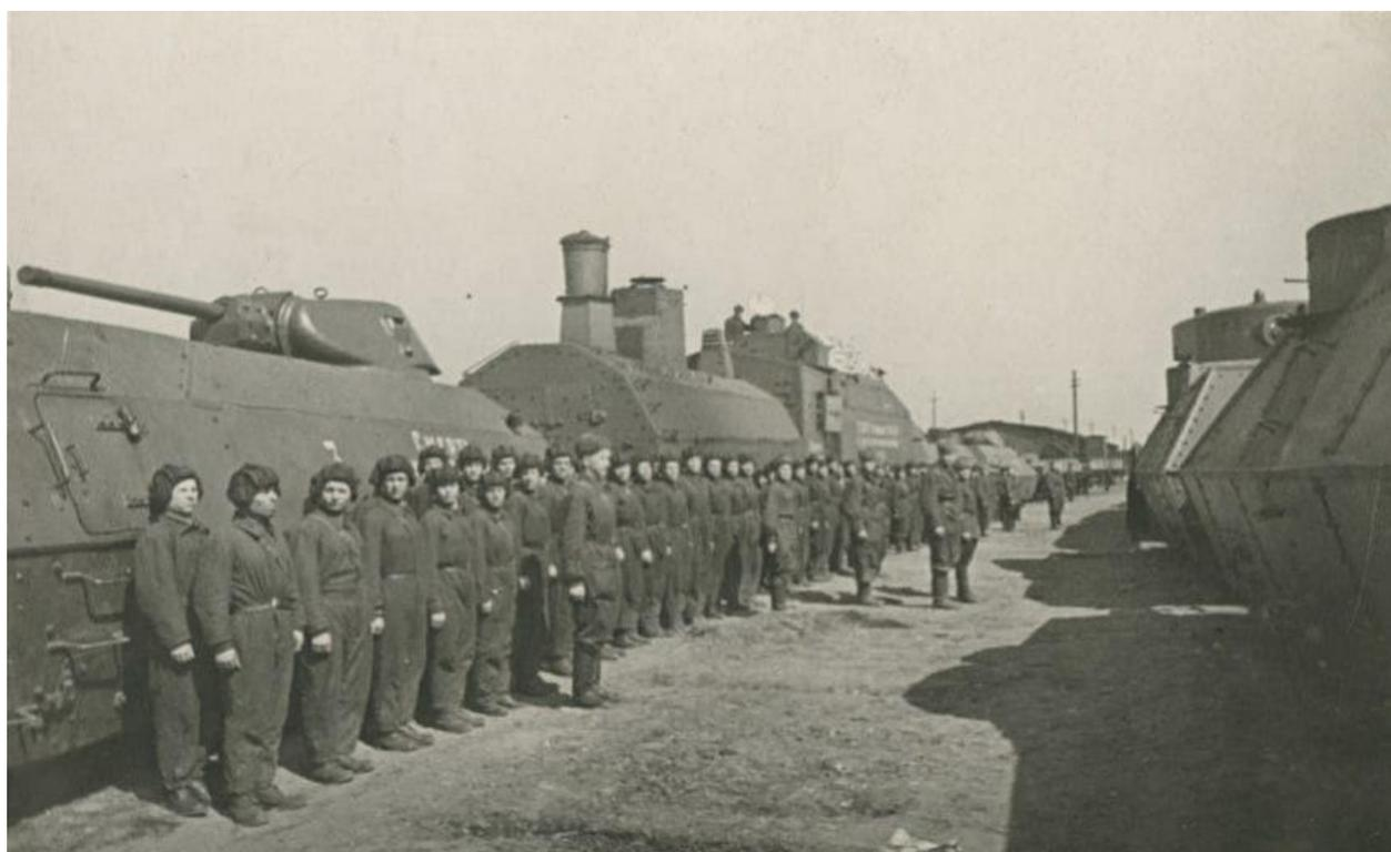
Бронепаровоз размещался посередине бронепоезда между бронеплощадками, а контрольные платформы в головной и хвостовой части.
